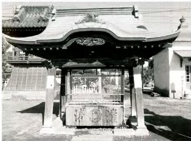
成田山川越別院水屋全景
