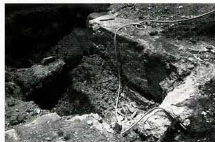
写真④ 旧「菅正」跡地工事現場 地下蔵と思われる
