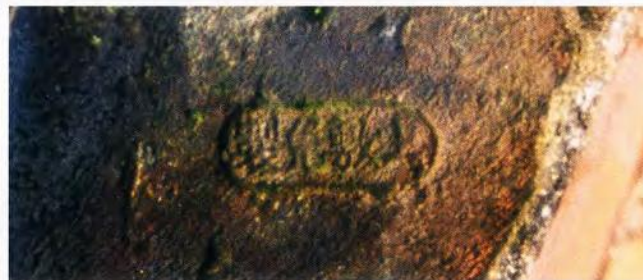
写真⑦ 上戸鉄橋橋台刻印煉瓦
