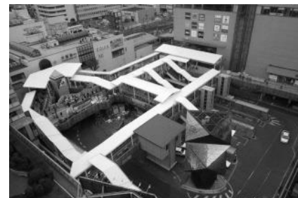
デッキ上屋根設置後の川越駅東口駅前広場
