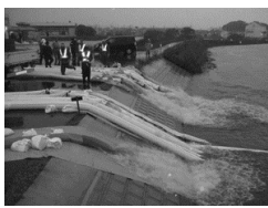
排水ポンプ車による応急排水
