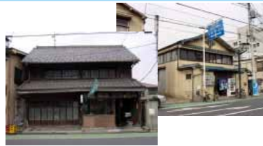
⑰⑱古くていい建物が残っている
