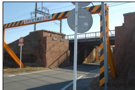
旧田面澤駅橋台
