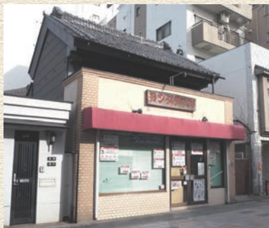
明治20年代後半建築(推定) 都市景観重要建築物
