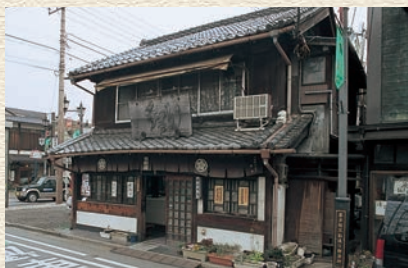
明治末～ 大正時代頃建築 都市景観重要建築物
