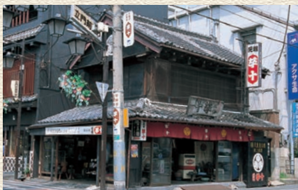
明治20年代 後半建築(推定) 都市景観重要建築物
