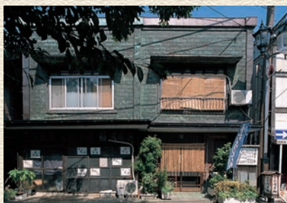
昭和4年頃建築 都市景観重要建築物
