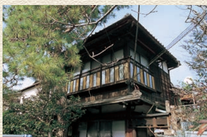
大正11年建築 景観重要建造物 令和2年修理
