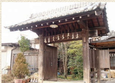
江戸後期建築 景観重要建造物
