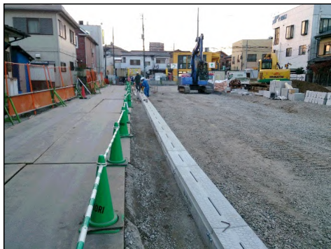
アクセス道路の側溝工事をしています。
