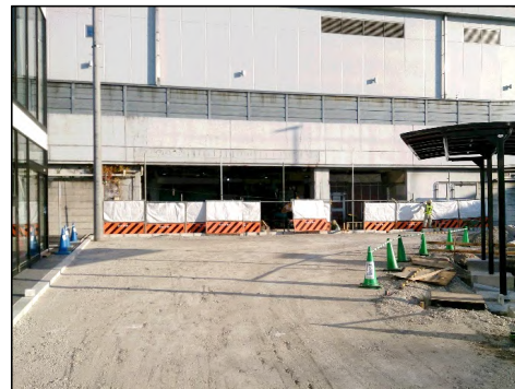
本川越駅西口開口工事をしています。
