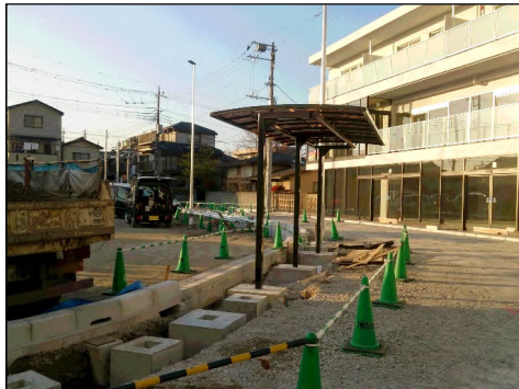
おもいやり乗降場のシェルターを設置しました。
