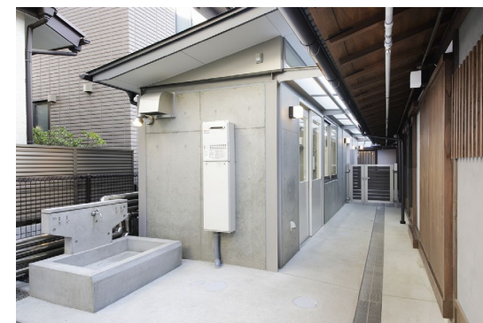
外観（東水廻り棟）
