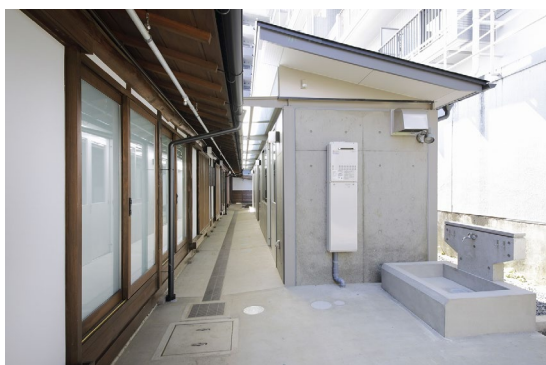
外観（西水廻り棟）
