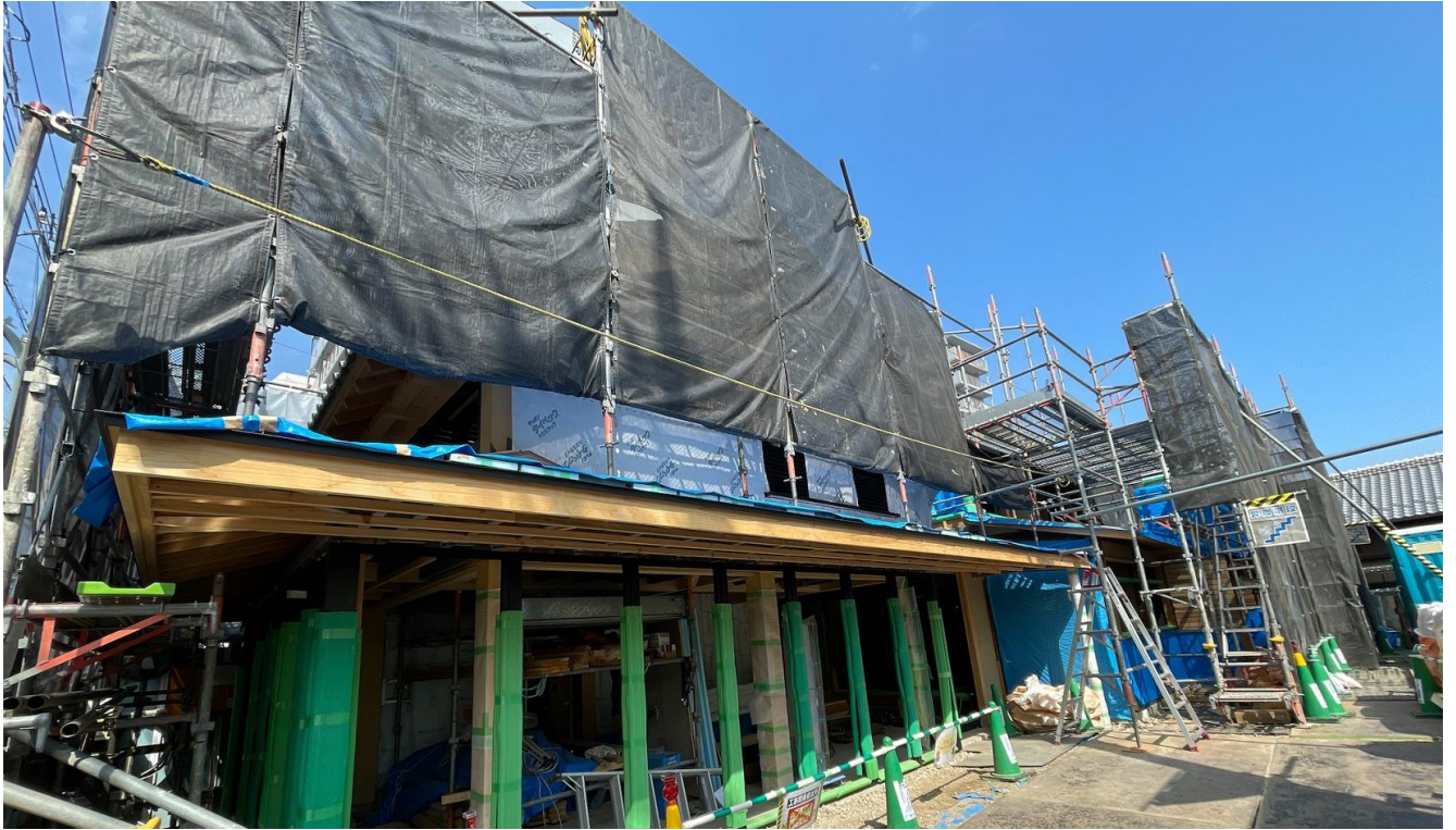
全景（令和5年4月 撮影）
