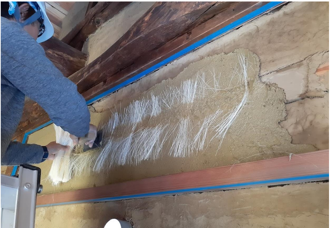
土壁塗りの施工状況
