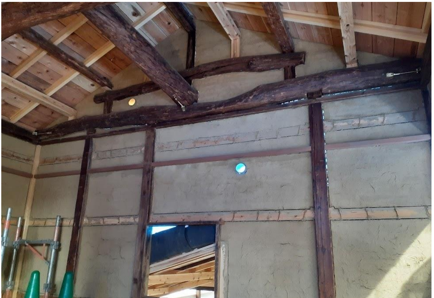
旧栄養食配給所住宅棟土壁の施工状況
