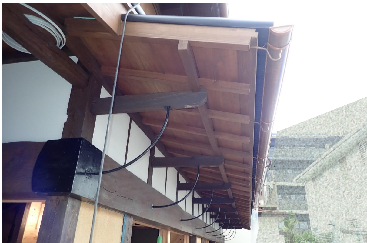
東棟南側庇の施工状況
