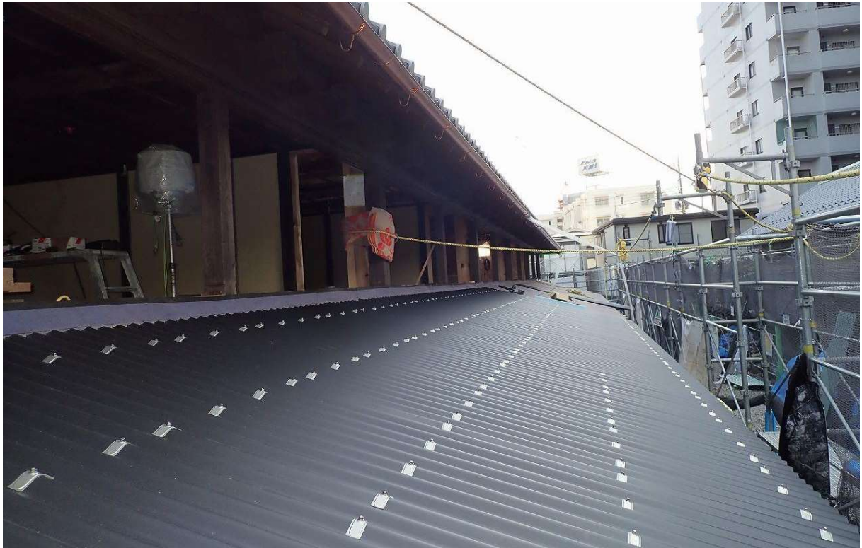
東棟土庇の施工状況
