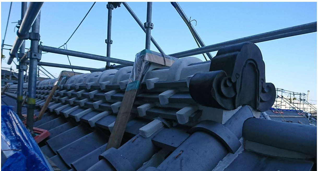
西棟の屋根工事
