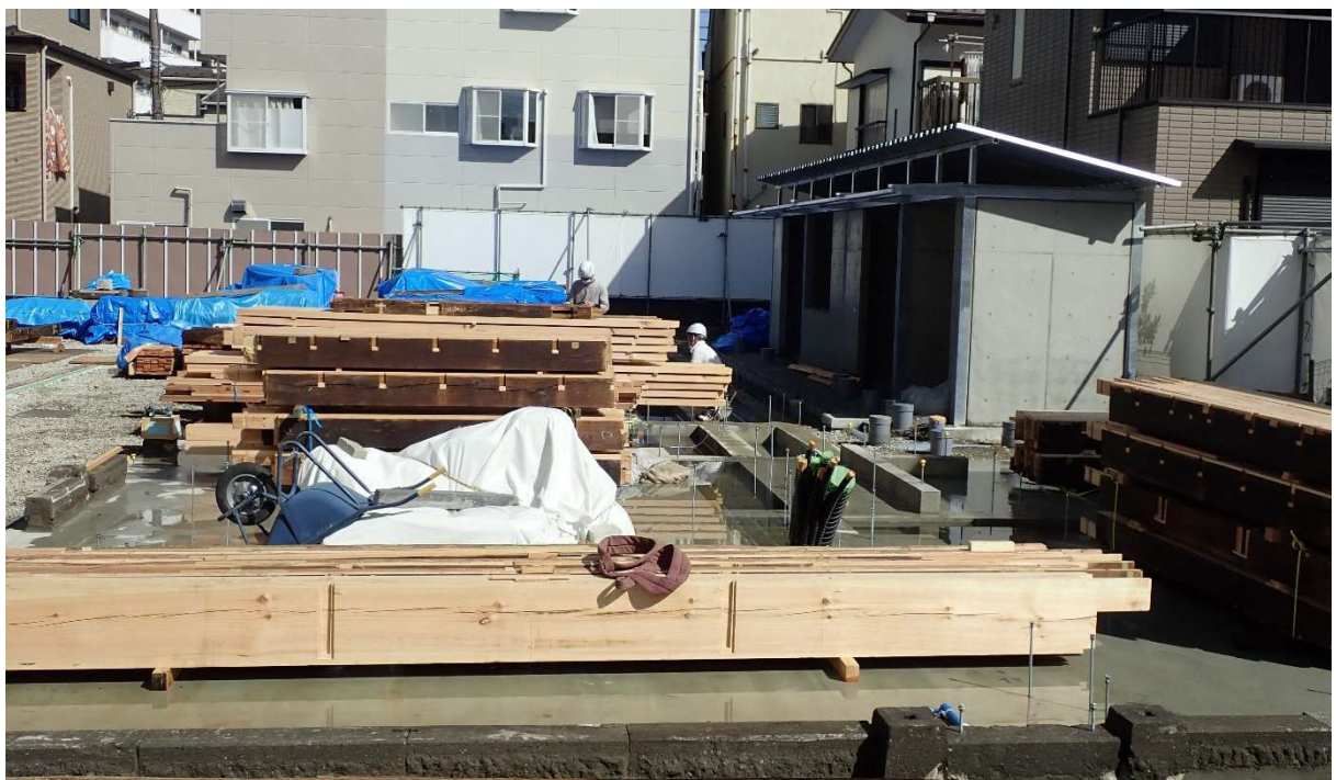
修復部材の現場搬入状況
