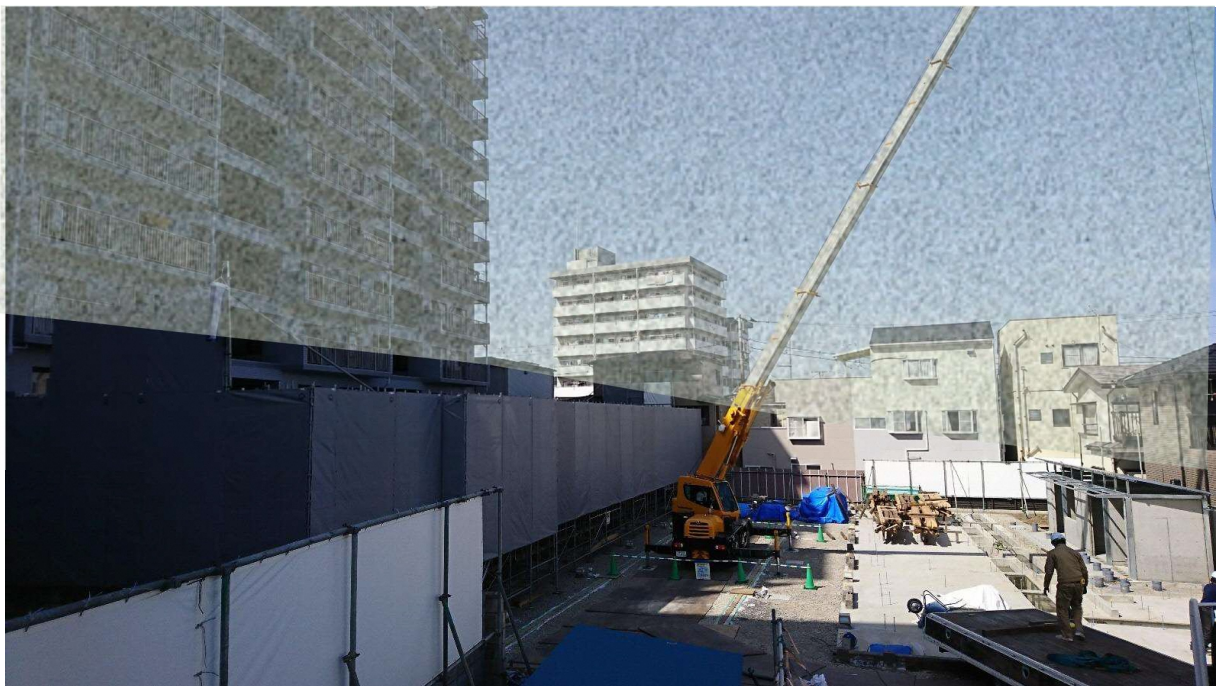
全景（令和3年3月下旬 撮影）
