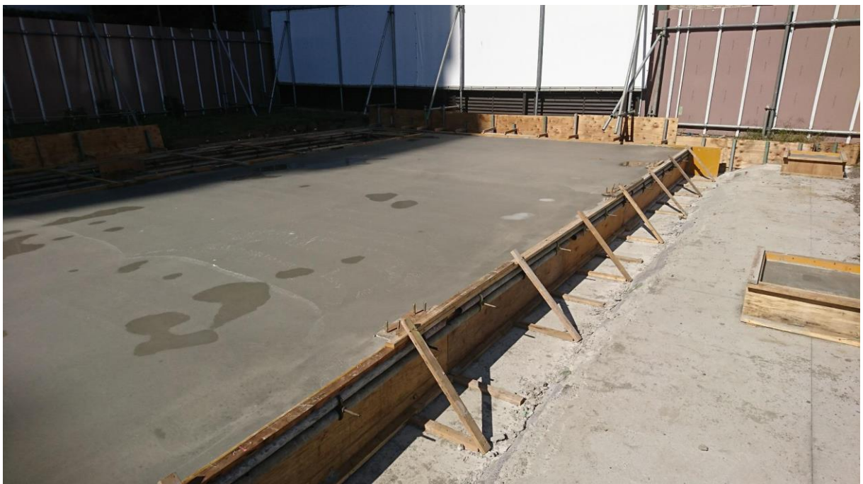
近景（令和2年10月下旬 撮影）
