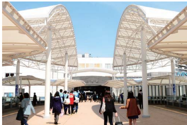
川越駅西口駅前広場
