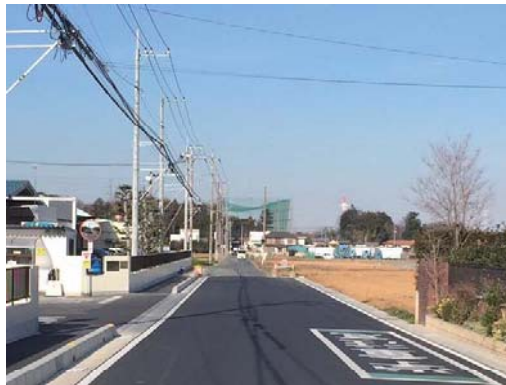
拡幅整備中の幹線道路（市道 0058 号線）
