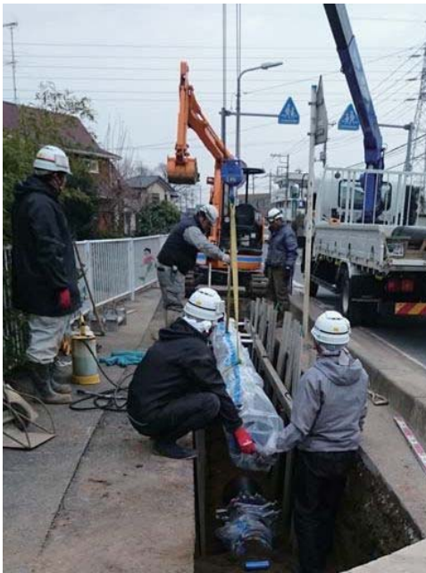
水道管布設工事
