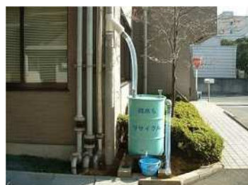
雨水利用(東清掃センター)
