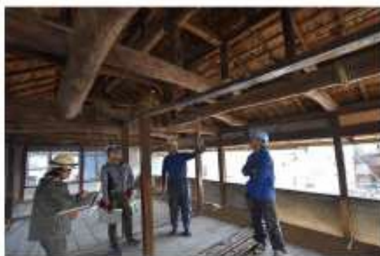
現場での検証の様子
