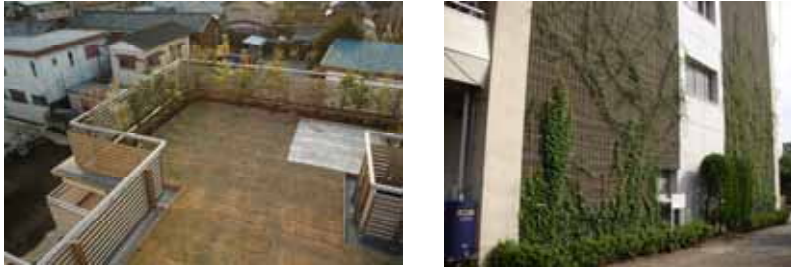
左：市民の屋上・壁面緑化、右：川越小学校の壁面緑化
