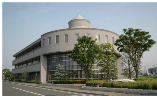
写真1 国道254号線側からみた川越市総合福祉センター（オアシス）
