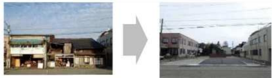
(例)居住環境の整備改善のため、特定空き家を除却
