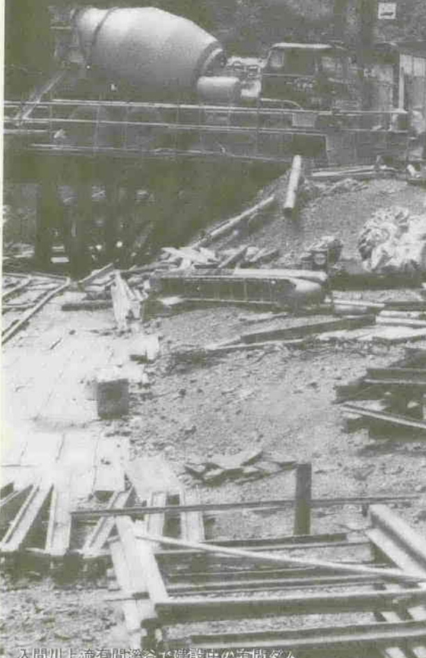
入間川上流有間溪谷で建設中の有間ダム
