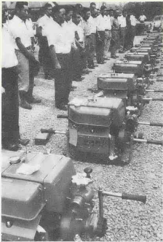
10自警隊に 消防ポンプの引渡し 管間ほか9つの自警隊に、可搬動力消防ポンプがこのほど市から引渡されました。このポンプは25馬力で1分間に最高830ℓの水を出すことができます。
