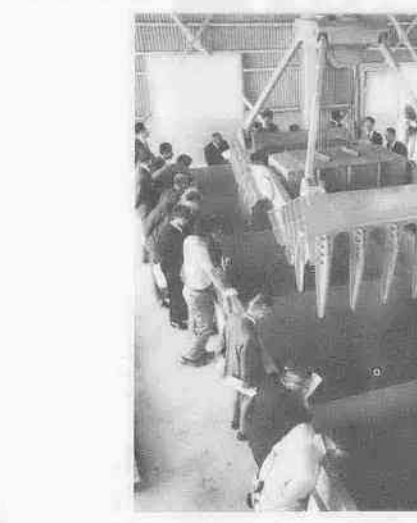
〔クレーンとごみ投入ホッパー〕
