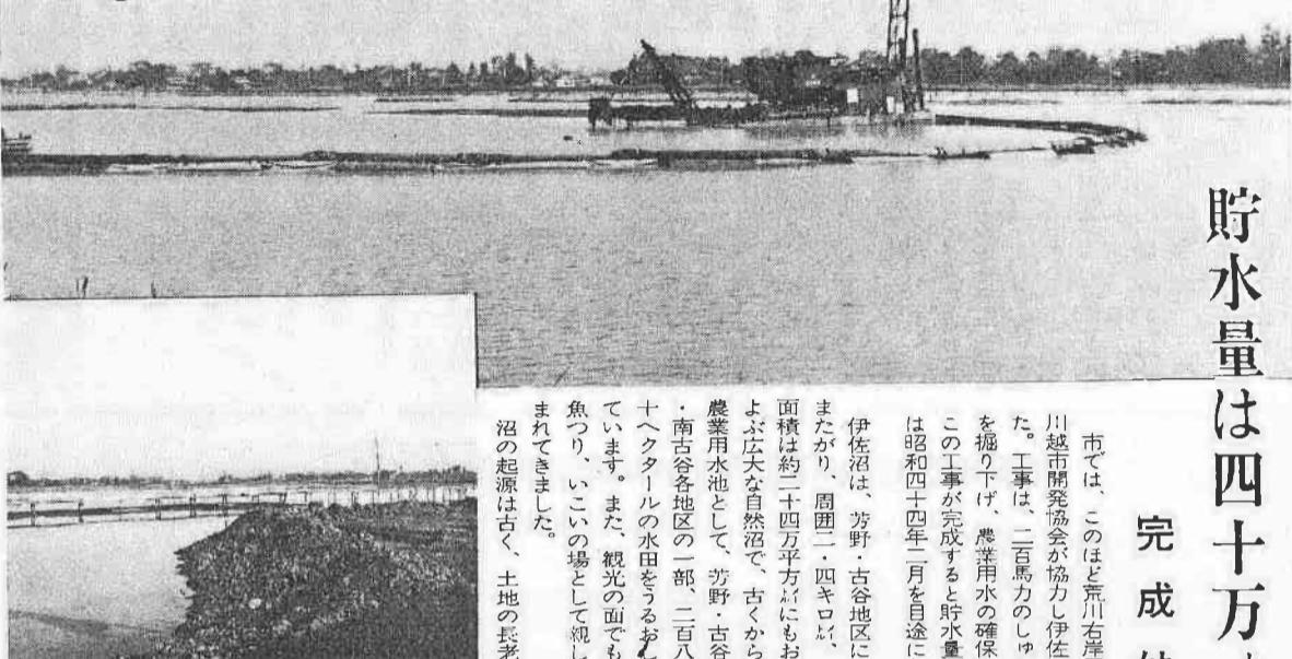
市では、このほど荒川右岸用排水土地改良区を中心として川越市開発協会が協力し伊佐沼池の改修工事に着手しました。工事は、二百馬力のしゅんせつ船を沼に浮かべ、沼の底を掘り下げ、農業用水の確保を目的で行なわれます。この工事が完成すると貯水量は四十二万となります。工事は昭和四十四年一月を予定して急ピッチですすめられています。
