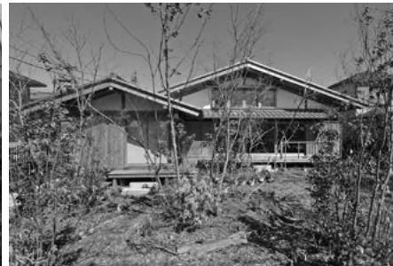
雑木の庭に建つ石場建ての家
