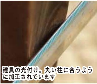
建具の光付け。丸い柱に合うように加工されています
