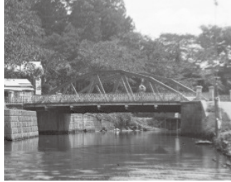
大正時代、鉄橋の高澤橋
