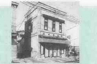
⑭太田屋茶店 所在地…久保町6-7 昭和4年建築 人造石仕上げの洋風の外観をした店舗。全体的に優しい感じの仕上げになっている。
