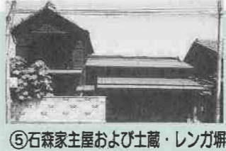
⑤石森家主屋および土蔵・レンガ塀 所在地…大手町2-9 主屋=明治26年ごろ建築 土蔵=明治5年ごろ建築 防火を考えて主屋を土蔵とレンガ塀で囲み、なおかつ延焼防止のために平屋建てにしたといわれる。
