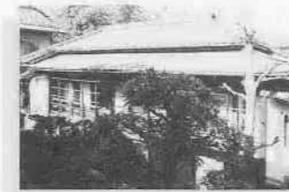
⑪佐久間旅館の間の間および塀 所在地…松江町2丁目5 明治44年建築 島崎藤村も愛用した川越屈指のお座敷。北側の塀は、昭和初期のものを改修。松江町の景観を形成。
