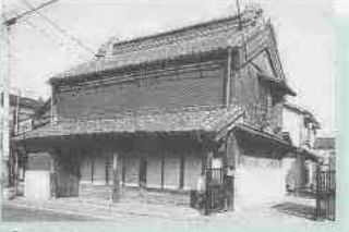
⑦星野家 所在地…松江町1丁目20-3 明治26年ごろ建築 土蔵造り商家で、道路側に2階の窓を持たないことや、下屋が吹き出しになっていることが特徴。
