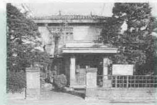
⑫佐々木医院本館・車小屋および門塀 所在地…連雀町31-3 昭和10年建築 昭和のはじめに流行した材料やデザインをバランスよく使った洋館で、昭和初期を代表する医院。
