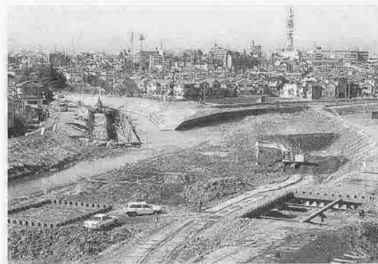
改修工事が進む新河岸川 (砂中学校校舎屋上から撮影)
