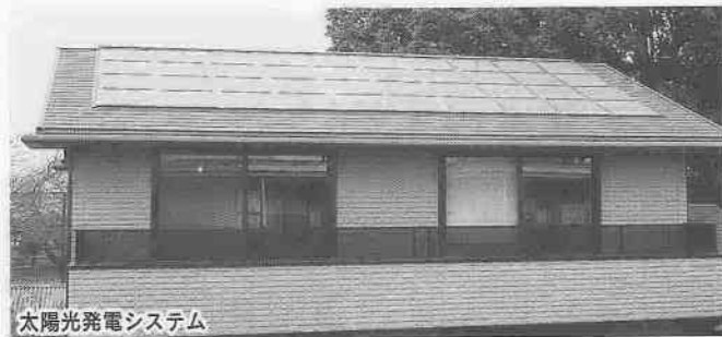
太陽光発電システム
