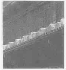
一文字瓦 瓦の下の部分が一直線
