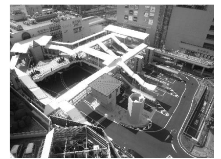
改修後の川越駅東口駅前広場
