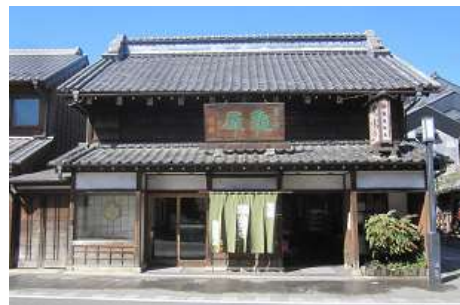
中島家住宅店棟（亀屋栄泉）
