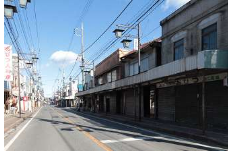
中央通り（看板建築）
