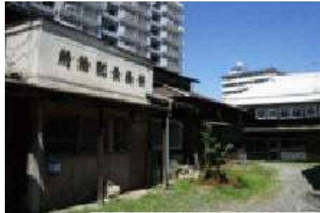
旧栄養食配給所
