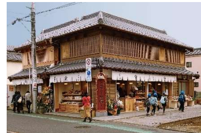
新築修景補助事業により建てられた建物 H29.3
