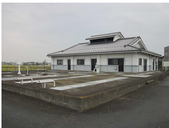
鴨田農業集落排水処理施設
