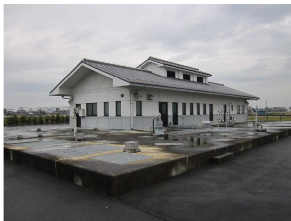
石田本郷農業集落排水処理施設
