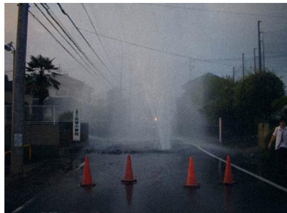
2008年8月の漏水状況
