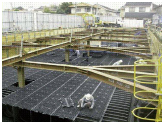
雨水貯留施設の整備
