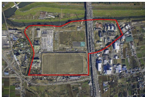
新河岸川水循環センター
