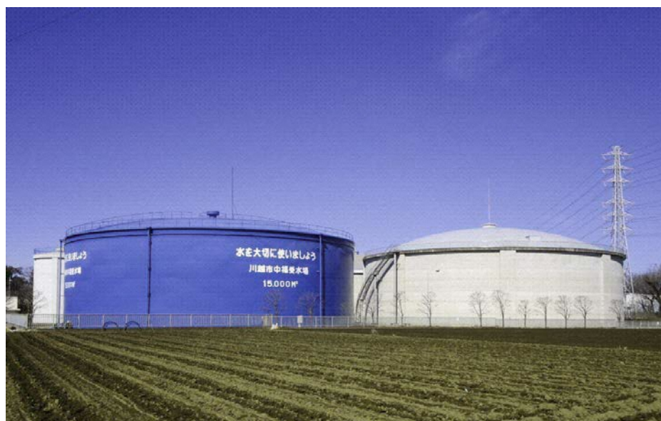
中福受水場配水池
