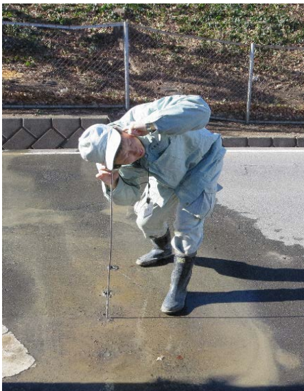
音聴棒を使った漏水調査
