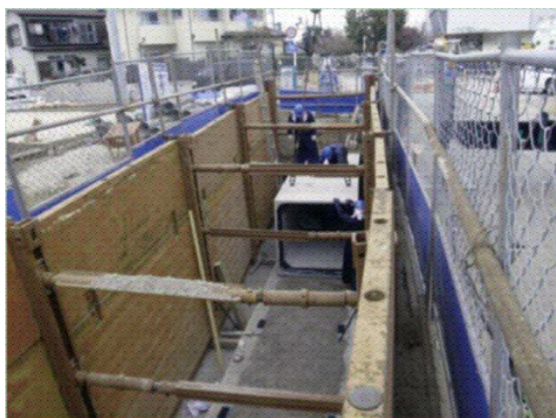
雨水管きよの整備
