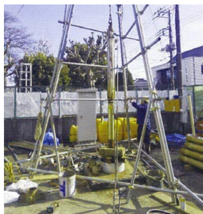
井戸修繕の様子
