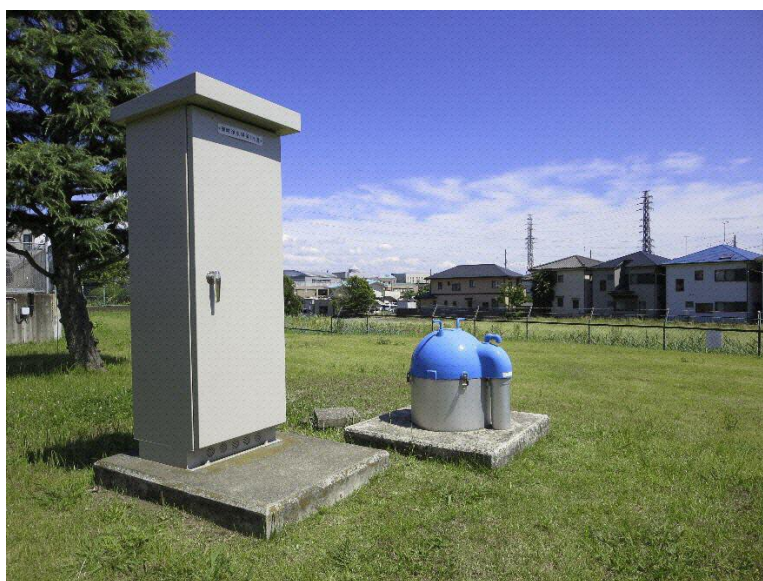
郭町浄水場第1水源
