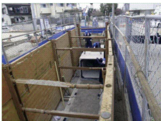
雨水管きよの整備
