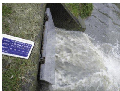
雨水吐口（雨天時）
