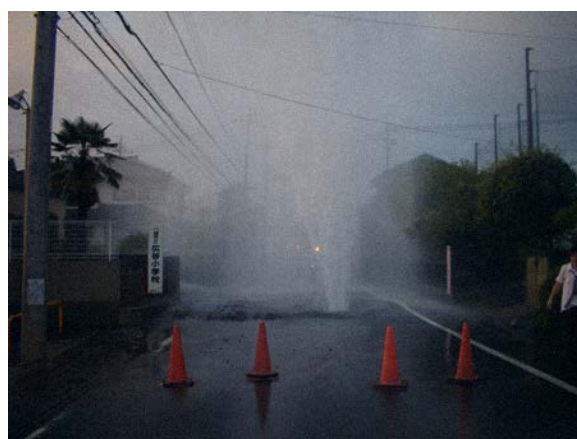
2008年8月の漏水状況
