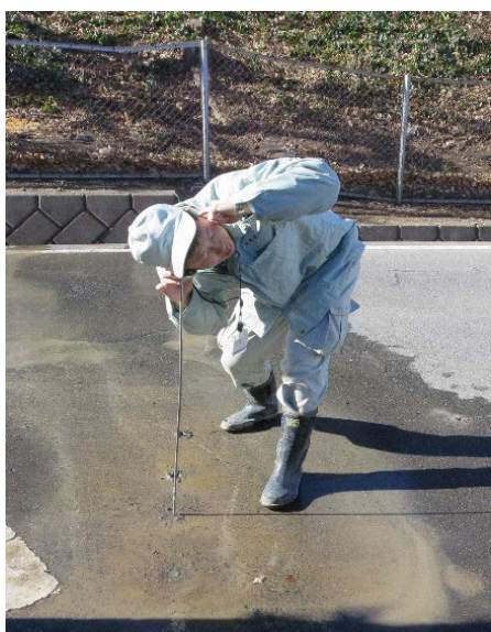
音聴棒を使った漏水調査
