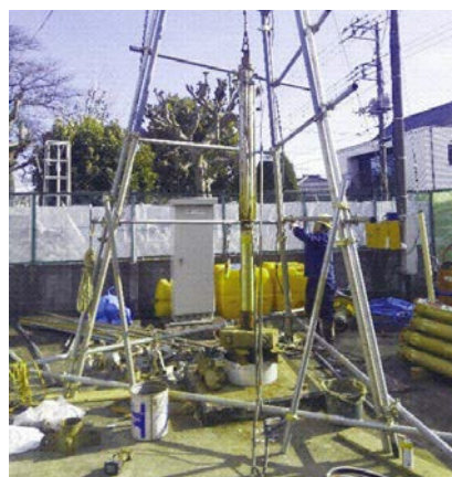
井戸修繕の様子
