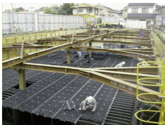
雨水貯留施設の整備
