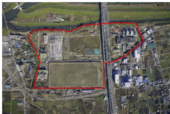
新河岸川水循環センター
