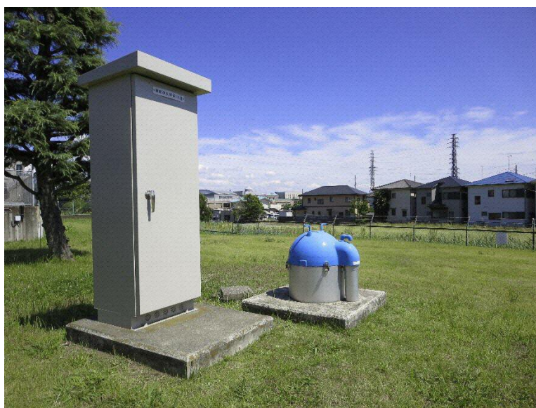
郭町浄水場第1水源
