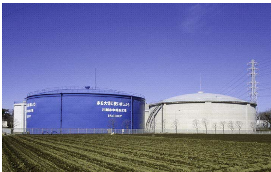
中福受水場配水池
