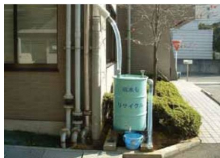
公共施設の雨水貯留施設
