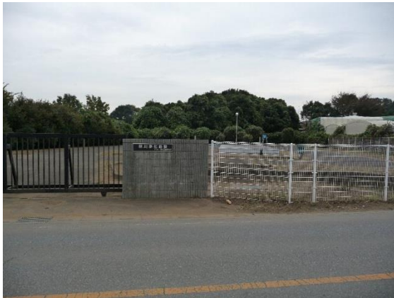
④林川浄化施設
