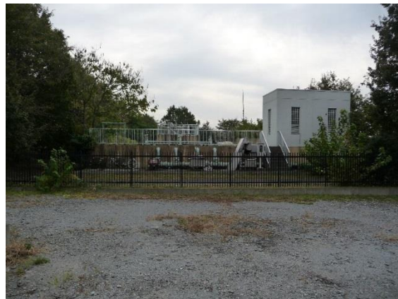
久保川浄化施設
