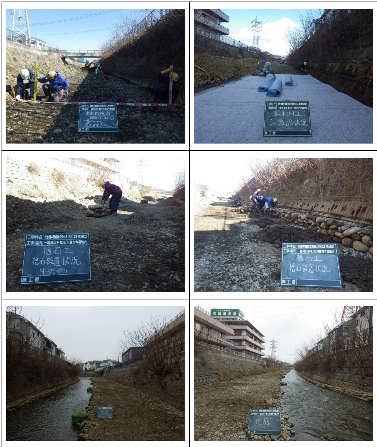
図 5.3 工事中および竣工時の状況
