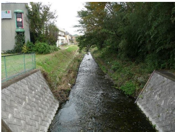
多自然型護岸に改修されている
