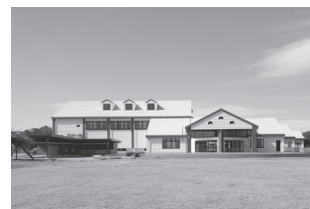
グリーンツーリズム拠点施設
