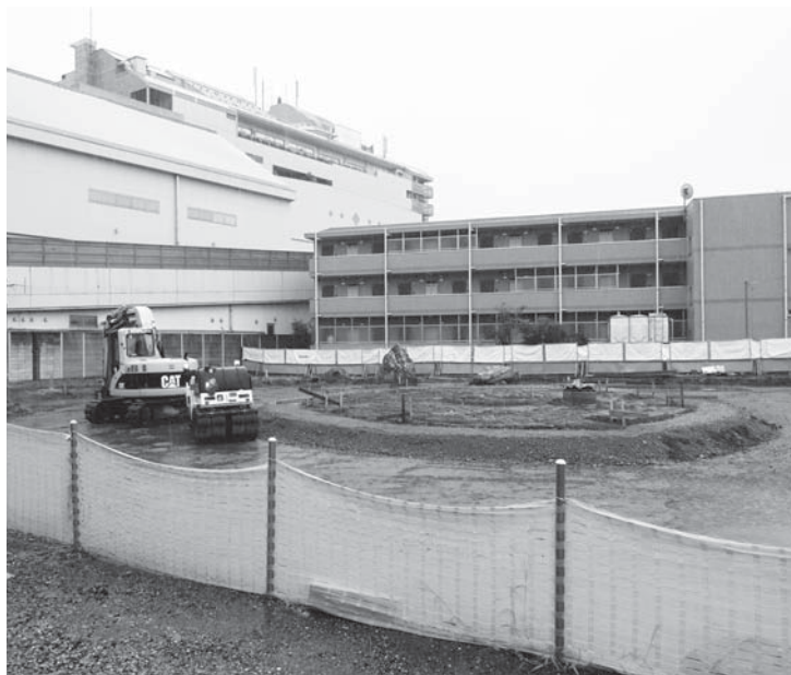
本川越駅西口駅前広場工事の様子
