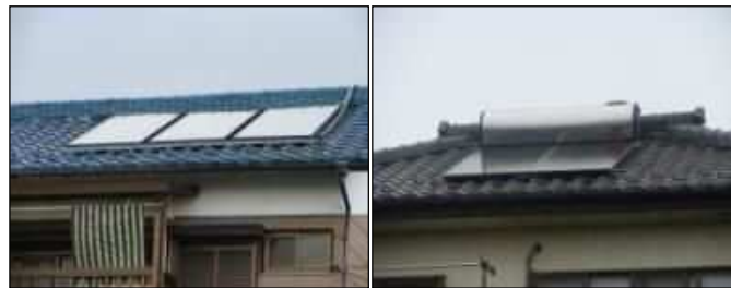
ソーラーシステム設置住宅 太陽熱温水器設置住宅
