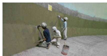
内壁モルタル塗りの様子
