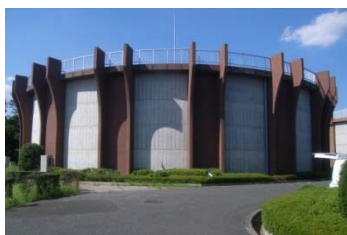
霞ヶ関第二浄水場 No.3 配水池外観
