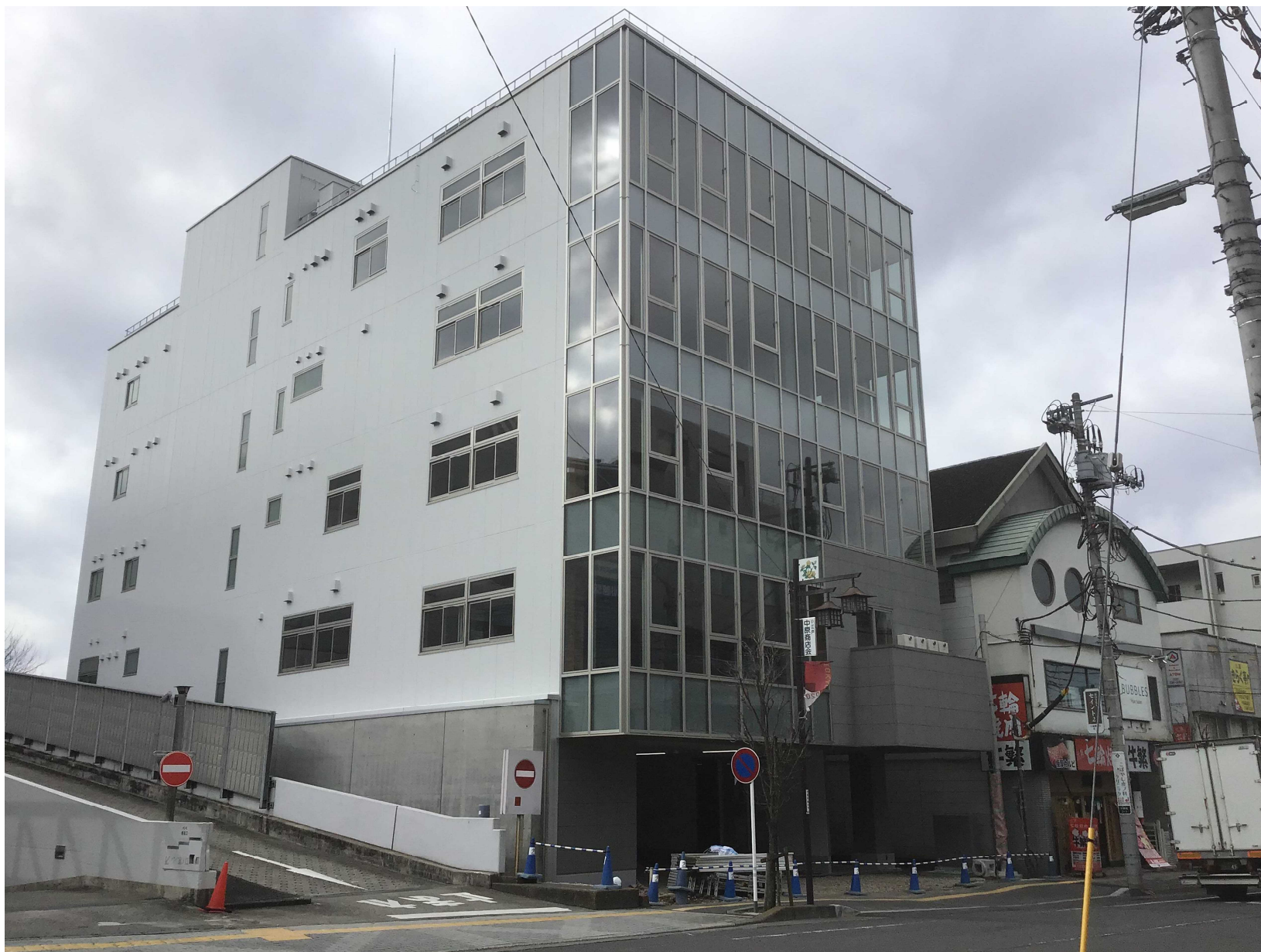
【内装工事完了】 (令和3年2月1日撮影)
