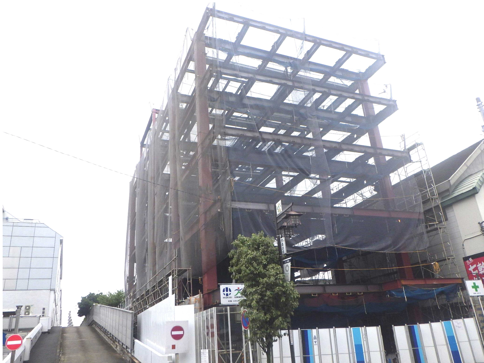
【建方工事完了】 (令和2年7月17日撮影)
