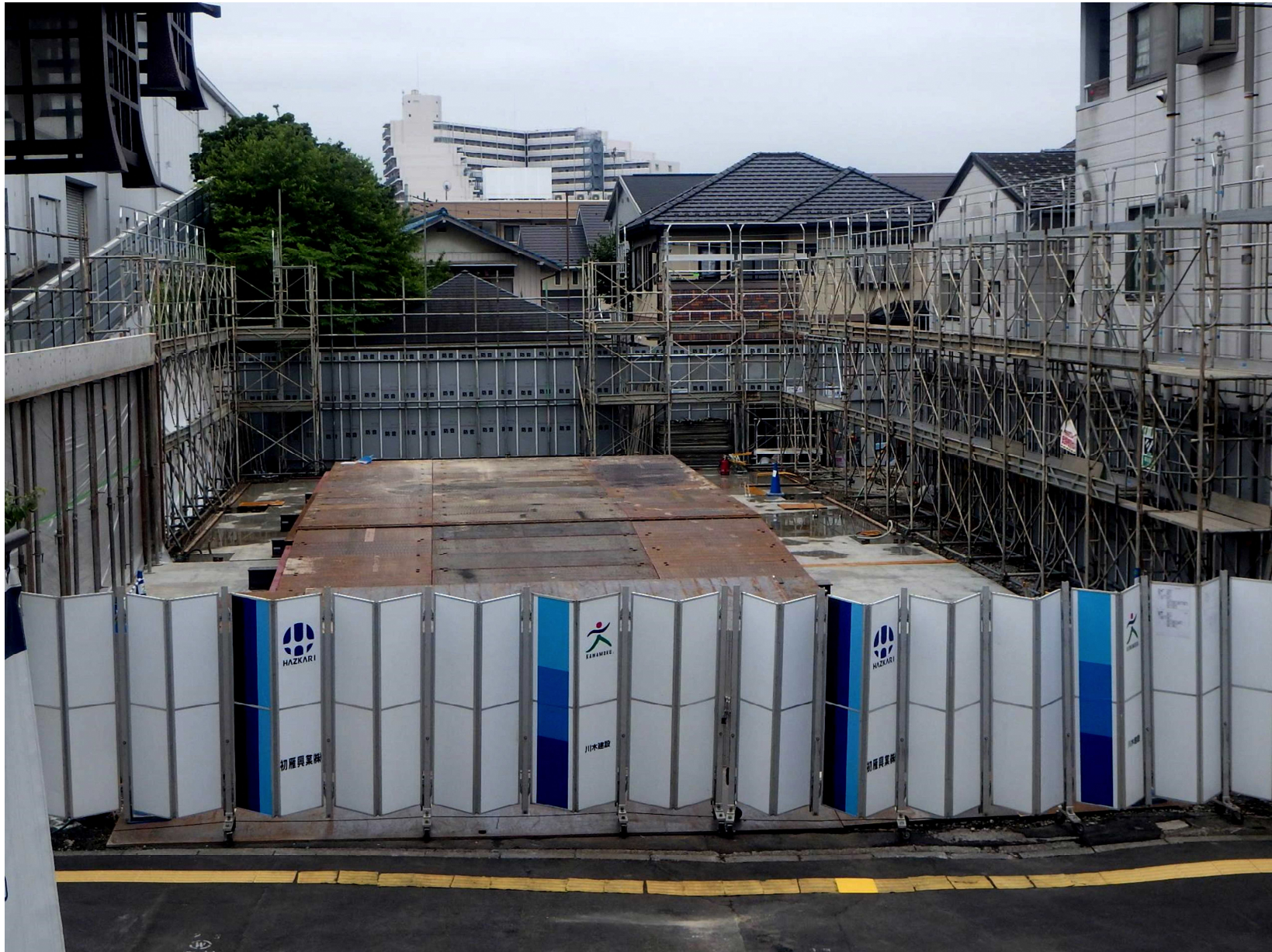
【基礎工事完了】 (令和2年6月25日撮影)
