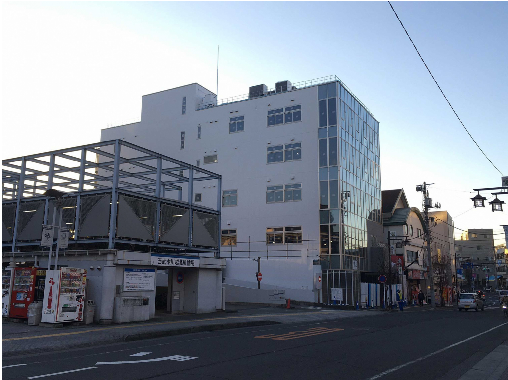
【内装下地工事完了】 (令和2年12月22日撮影)
